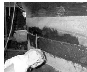
◀ Abb.9: Einbringen eines Rohrschusses am Schornsteinfuß
