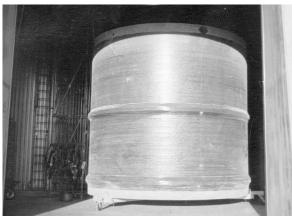
◀ Abb.9: Einbringen eines Rohrschusses am Schornsteinfuß
