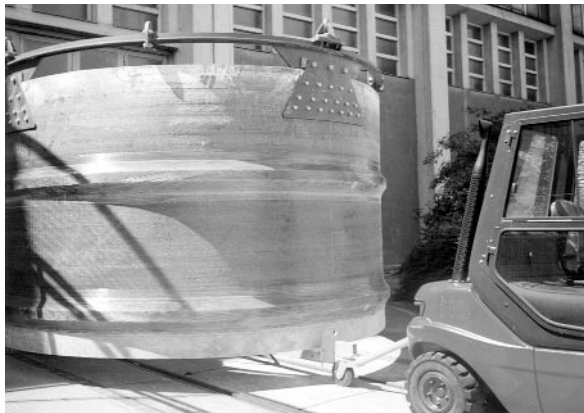
Abb.8: Hebevorrichtung aus Stahl am obersten GFK-Schuss
